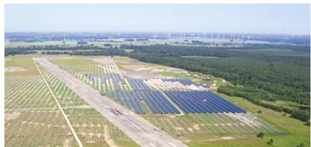
Photovoltaikkraftwerk Alt Daber, Stand Juni 2011
