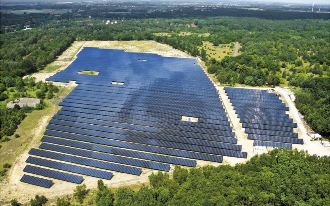
Photovoltaik-Kraftwerk Wünsdorf, Stand Juni 2011
