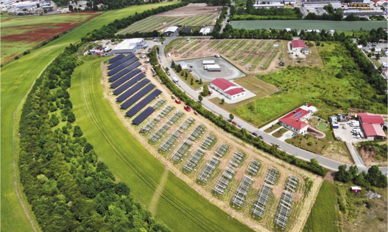
Photovoltaikpark Laucha, Stand Juni 2011
