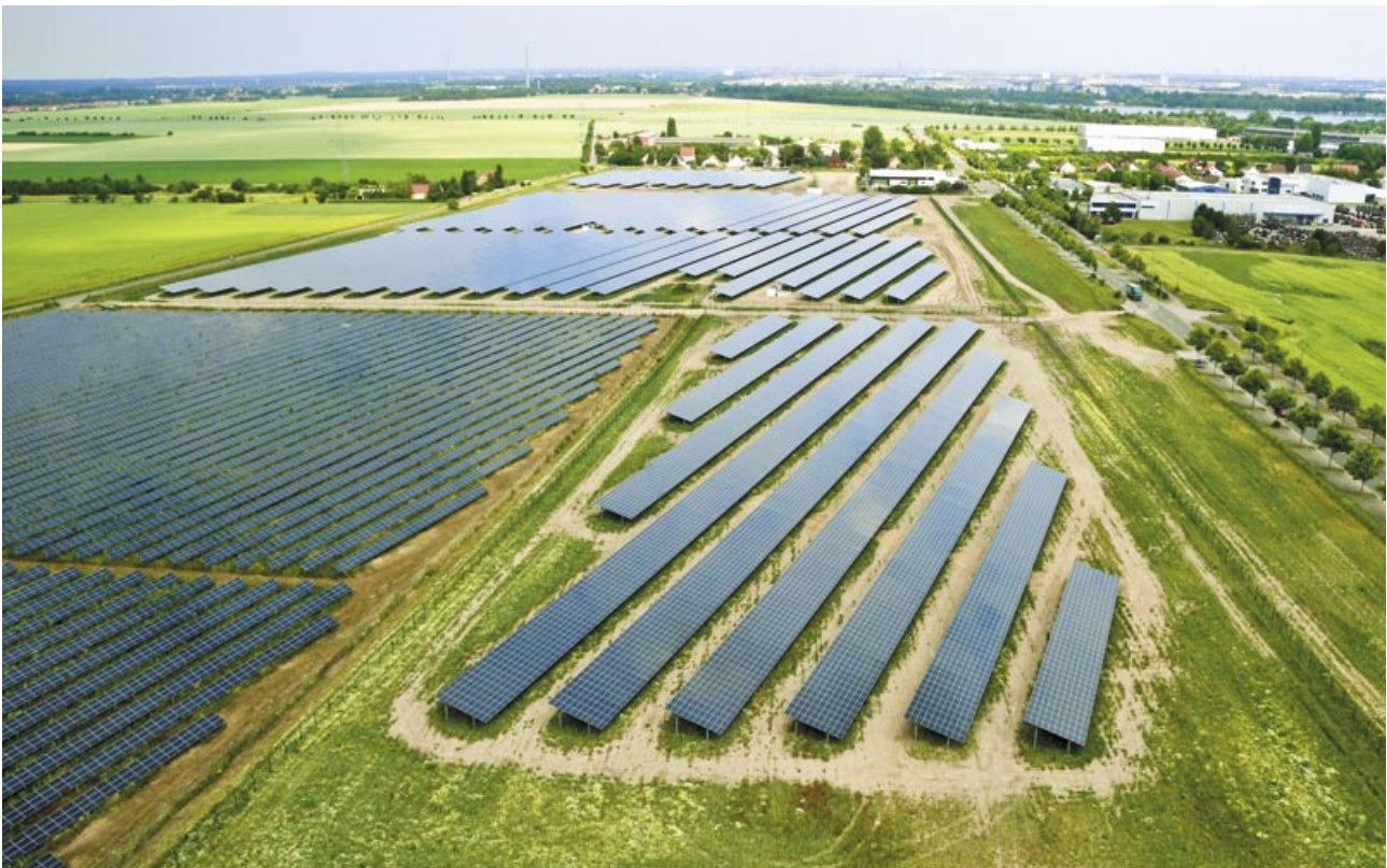
Photovoltaikkraftwerk Markranstädt, Stand Juni 2011
