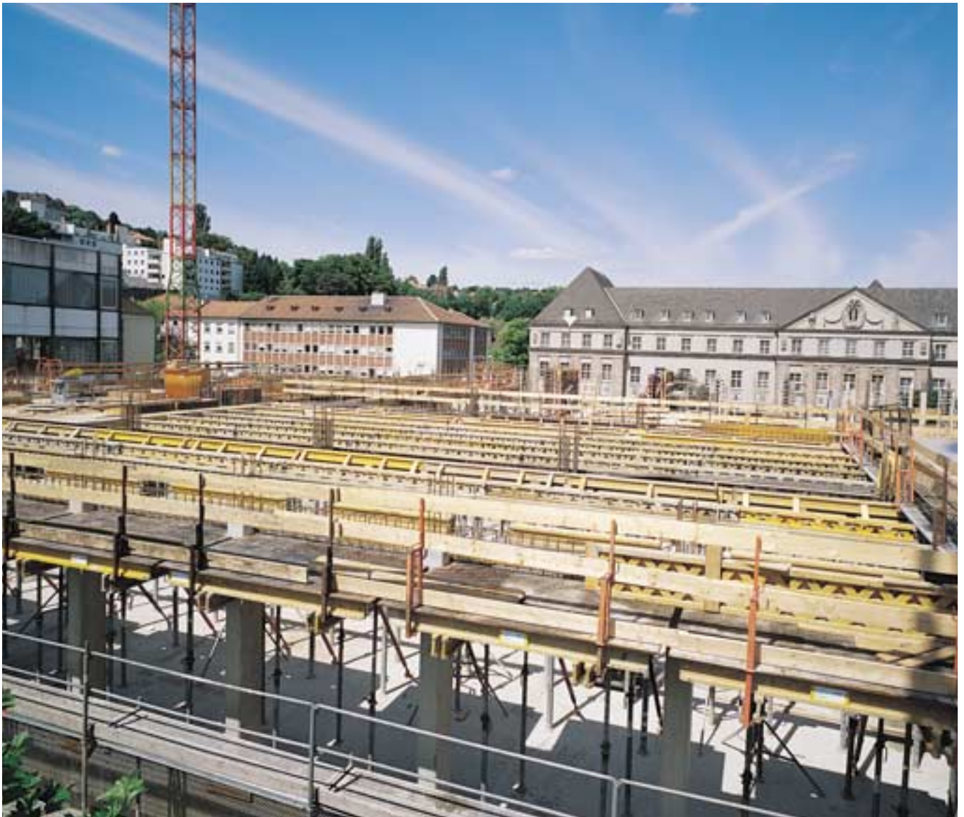
Blick über die Baustelle auf das Amtsgericht
