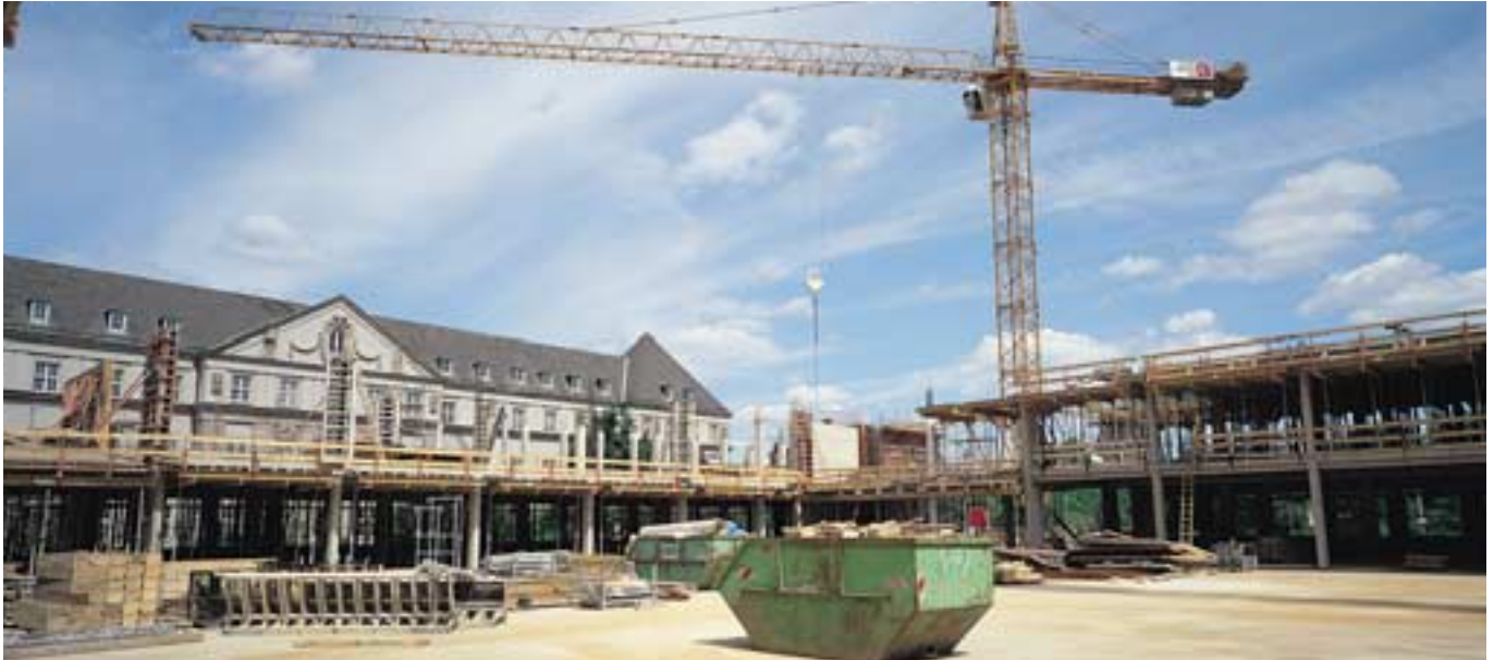
ATRIUM im Rohbau mit Blick auf das Amtsgericht
