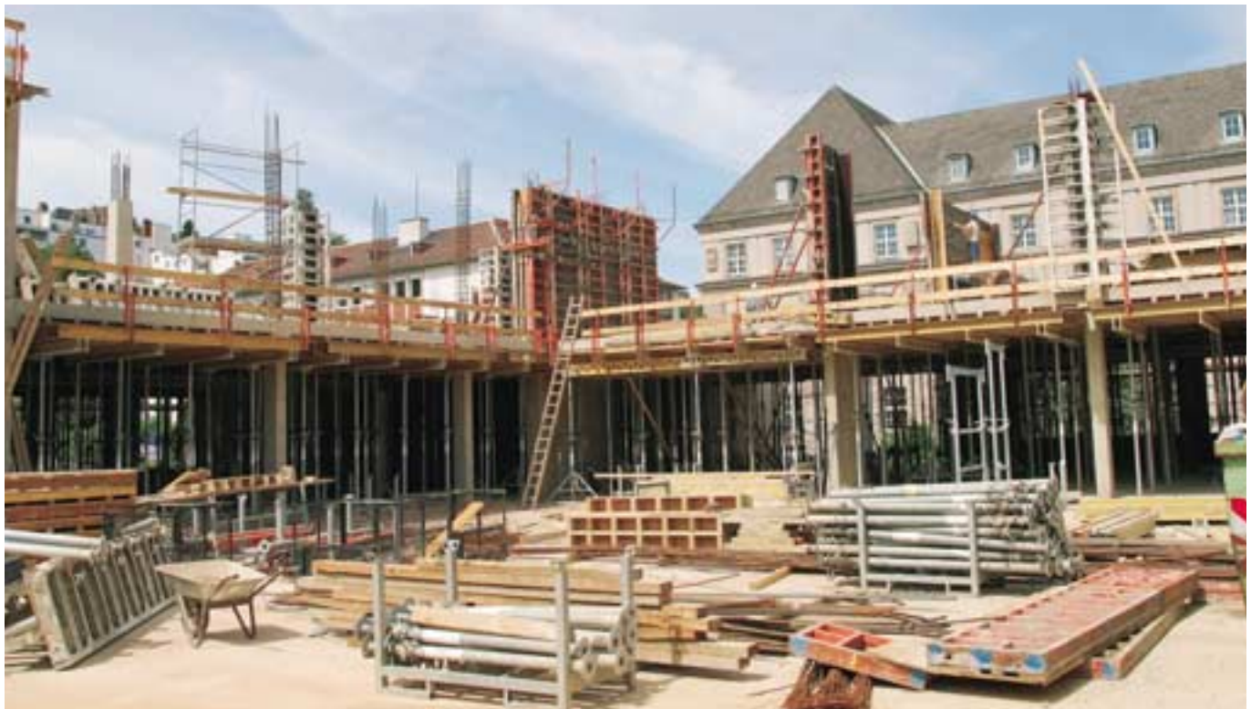
ATRIUM im Rohbau
