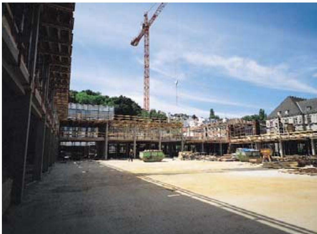
ATRIUM im Rohbau
