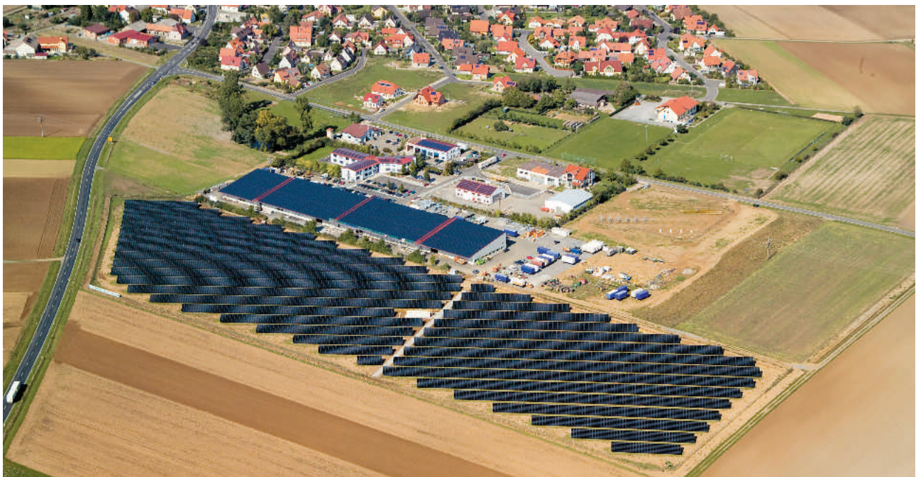
Photovoltaik Zentrum Kolitzheim
