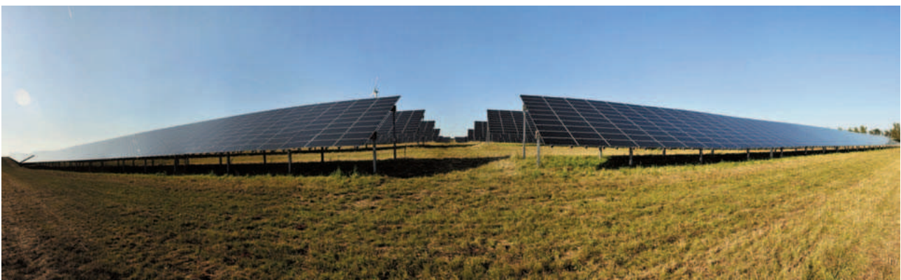
Panorama vom Solarkraftwerk Repperndorf
