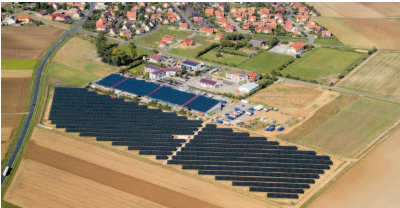
Photovoltaik Zentrum Kolitzheim
